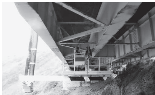
写真-1 橋梁点検車での床版下面の点検状況
