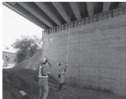
写真-2 梯子が掛けづらい床版下面の点検状況
